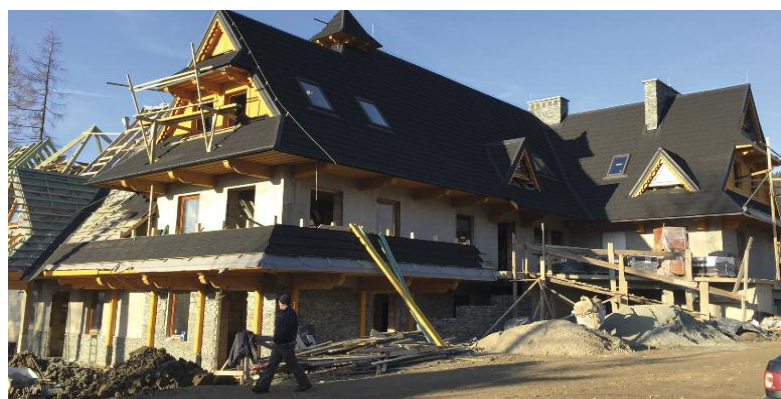
Budynek wielofunkcyjny w Dzianisz w trakcie budowy
