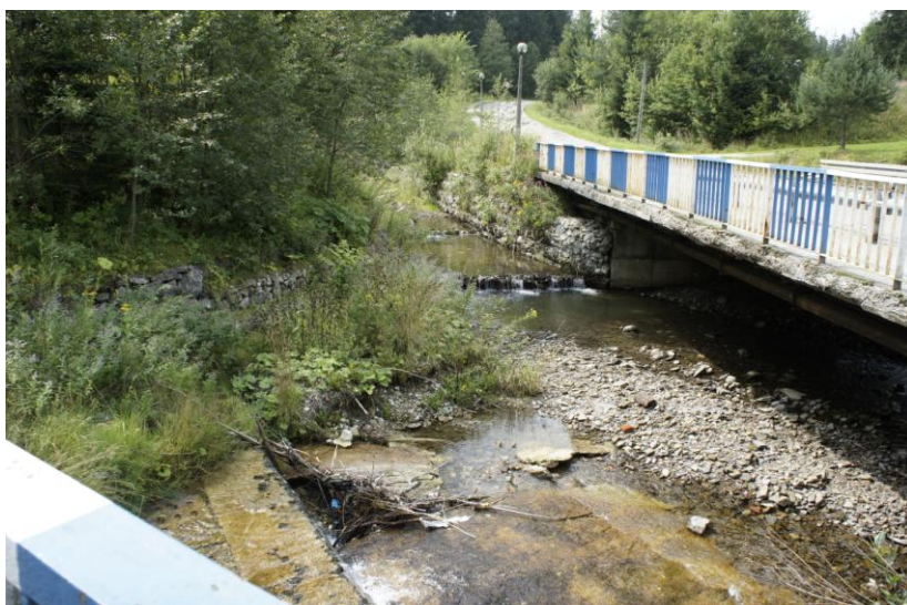
Fot. 10 Zabudowa hydrotechniczna potoku Cicha Woda w rejonie ulicy Sywarne
